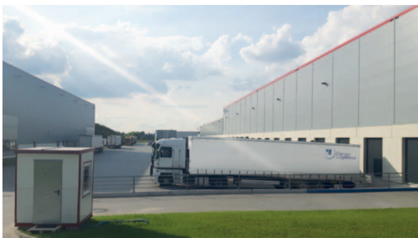
W dystrybucji krajowej przeważającą część stanowi dystrybucja nocna. I chociaż CAT LC w Polsce ma najlepiej rozwiniętą sieć tej dystrybucji, jego ambicją jest dalsze jej doskonalenie. Z tym wiążą się kolejne projekty związane z rozbudową infrastruktury
